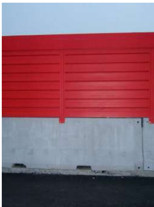
Fig. 51 – Tipologico esemplificativo della recinzione a delimitazione cantiere in Via Botticelli TORINO
