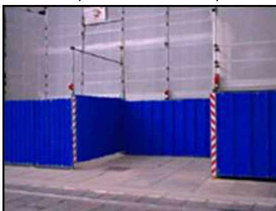
Fig. 51 – Esempio di recinzioni per le attività in corrispondenza del lotto di intervento.
